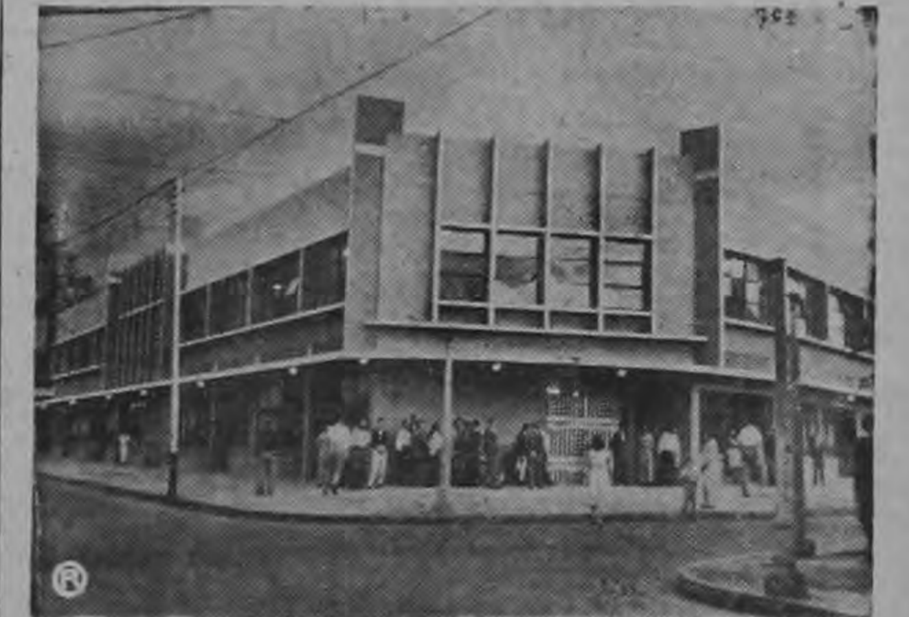
NUEVO MERCADITO DEL SUR — Esta magnífica gráfica de Solano, muestra un aspecto del nuevo Mercadito del Sur, construido por la Municipalidad de San José. El edificio fué levantado con un costo de $500.000 sin contar la propiedad. La Municipalidad tiene la intención de construir cinco de estos mercaditos en diferentes sectores de la capital y en esta forma, completar su plan de mercados periféricos, que indudablemente prestarán un importante servicio a la comunidad. (FOTO SOLANO)
